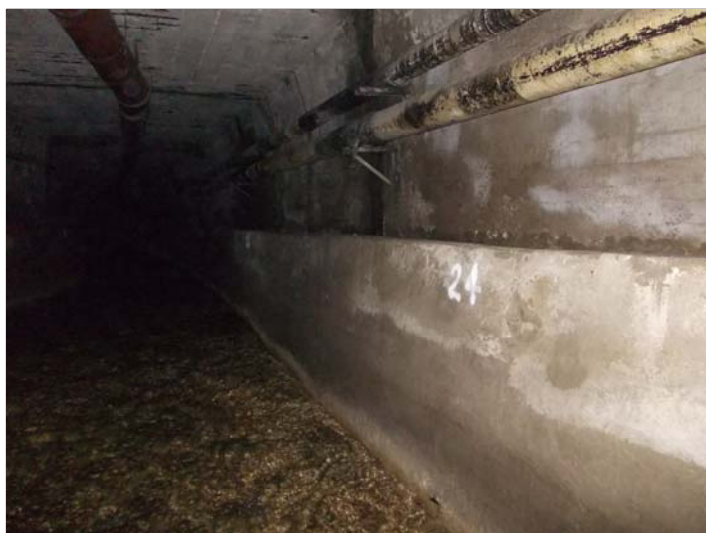
Foto 2 - Piedritto sx - canaletta laterale - condotta fognaria Dn 400 Pvc
