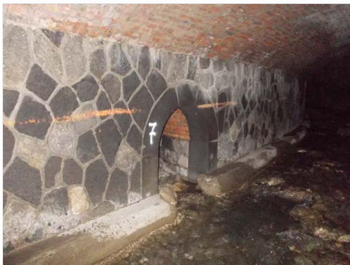
Foto 2 - Panoramica piedritto dx - ghiaia depositata
