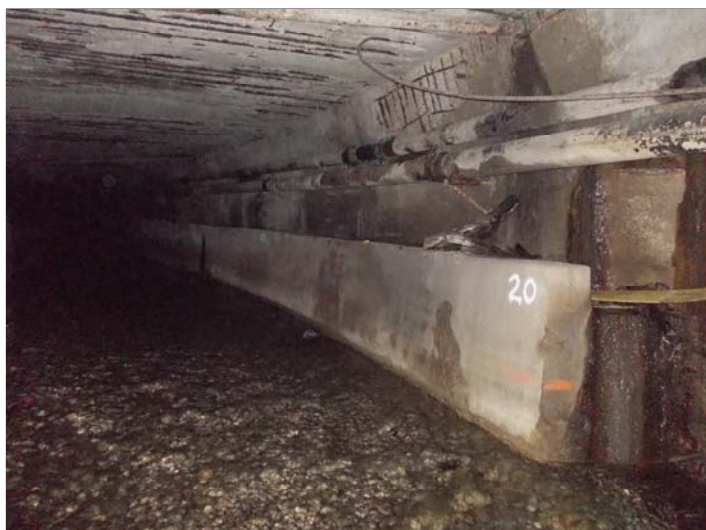
Foto 3 - Panoramica - ghiaia depositata - condotte longitudinali Dn 200 e Dn 150
