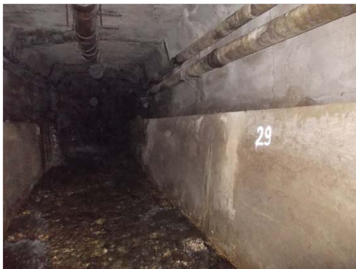
Foto 2 - Piedritto sx - canaletta laterale - ghiaia sul fondo
