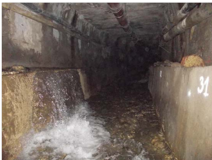
Foto 2 - Piedritto dx - canaletta laterale ostruita - ghiaia sul fondo
