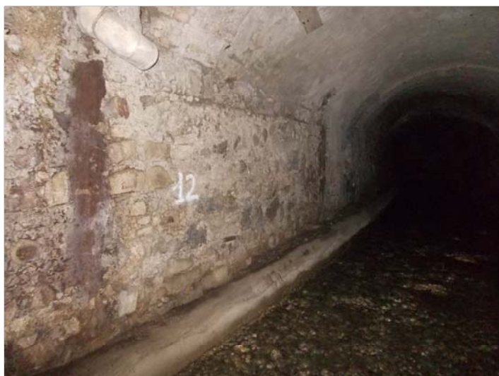
Foto 2 - Panoramica piedritto sx - immissione
