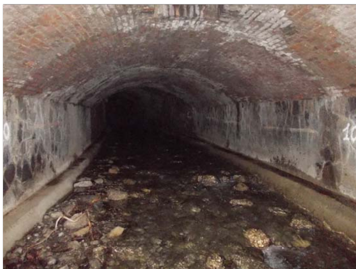
Foto 3 - Pozzetto Pz2 - copertura a volta in mattoni pieni - ghiaia depositata
