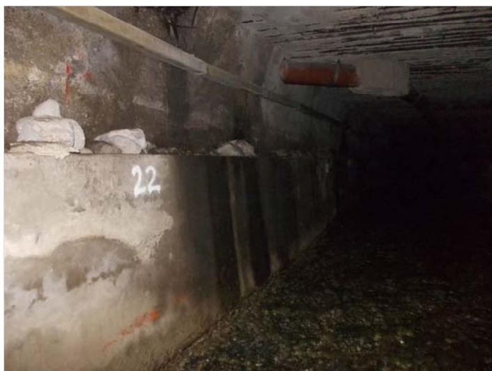
Foto 2 - Piedritto sx - canaletta laterale - ghiaia depositata - canaletta per cavi
