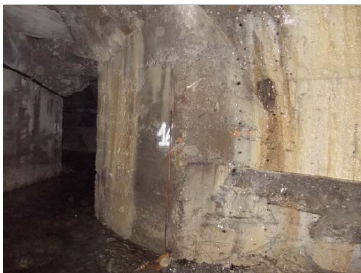
Foto 2 - Panoramica piedritto dx - ghiaia depositata
