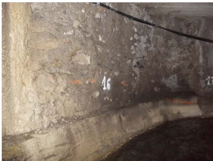
Foto 2 - Panoramica piedritto dx - ghiaia depositata
