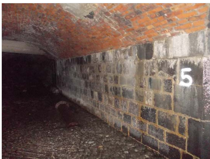
Foto 2 - Panoramica piedritto dx - ghiaia depositata
