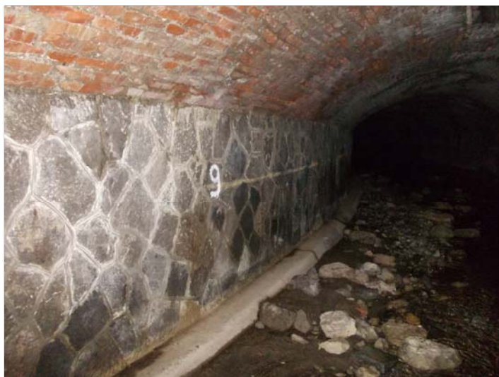
Foto 1 - Panoramica piedritto sx - ghiaia depositata sul fondo
