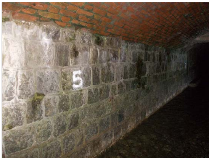
Foto 1 - Panoramica piedritto sx ghiaia depositata sul fondo
