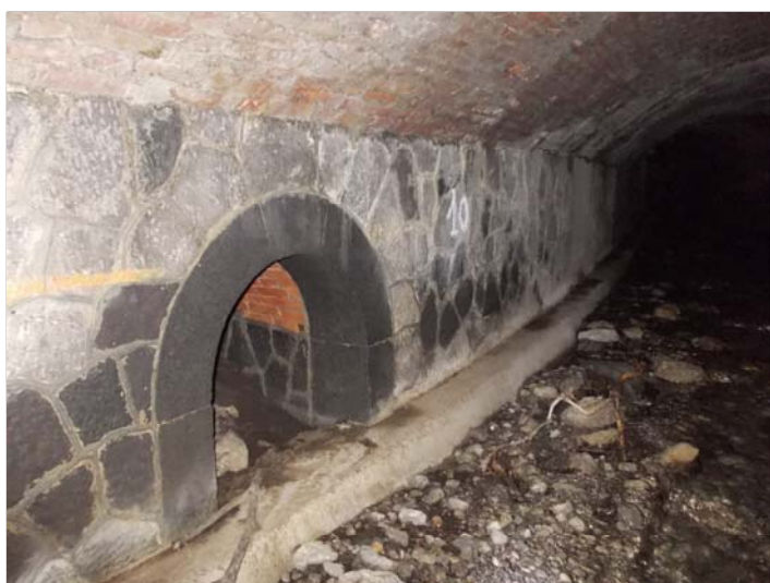
Foto 2 - Panoramica piedritto sx - immissione
