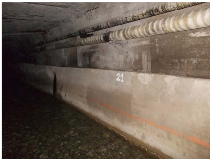
Foto 2 - Piedritto sx - canaletta laterale - canaletta per cavi
