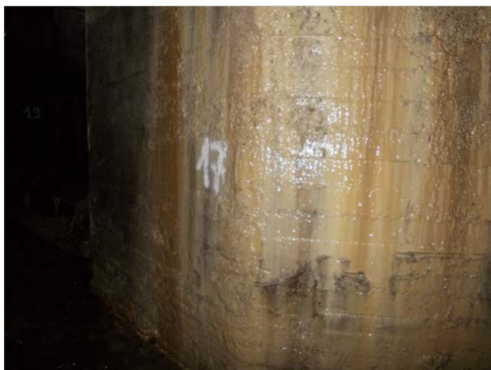
Foto 2 - Panoramica piedritto dx - infiltrazione dalla superficie
