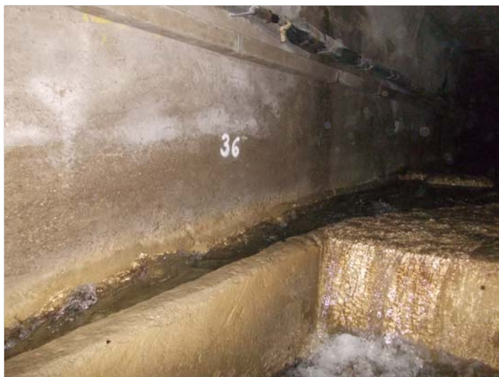
Foto 2 - Piedritto dx - canaletta laterale - salto di quota
