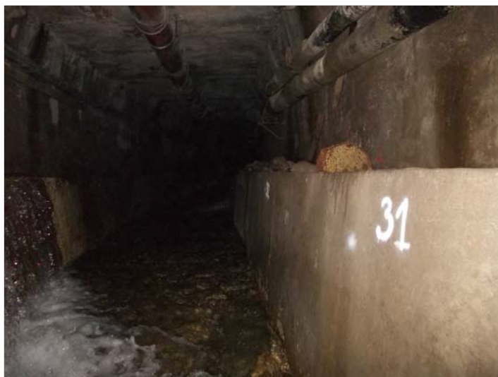
Foto 2 - Piedritto dx - canaletta laterale ostruita - ghiaia sul fondo
