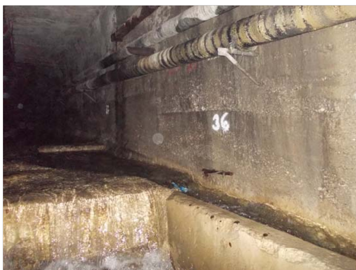
Foto 2 - Piedritto dx - canaletta laterale - salto di quota
