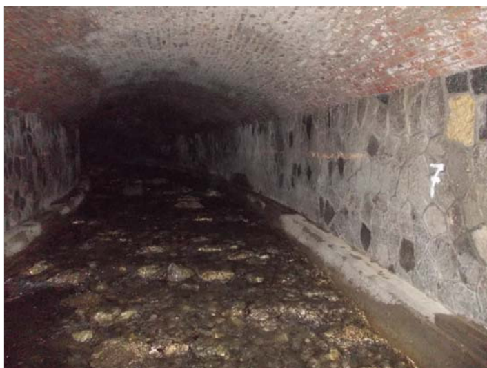
Foto 3 - Panoramica copertura a volta in mattoni pieni - ghiaia depositata
