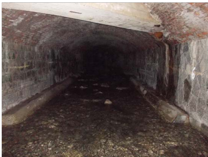
Foto 3 - Panoramica copertura a volta in mattoni pieni - trave in cls
