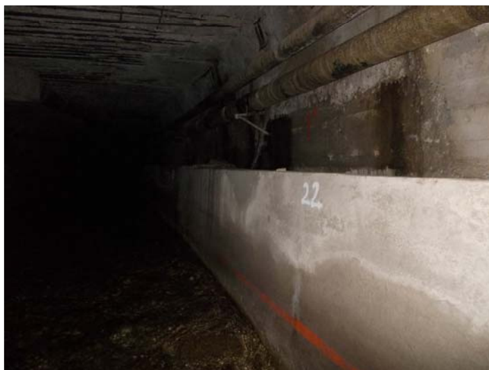
Foto 1 - Piedritto dx - canaletta laterale - condotte longitudinali Dn 200 e Dn 150
