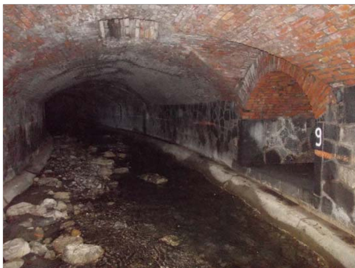
Foto 3 - Pozzetto Pz1 - copertura a volta in mattoni pieni - ghiaia depositata
