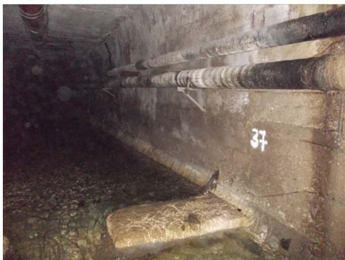
Foto 2 - Piedritto dx - canaletta laterale - salto di quota
