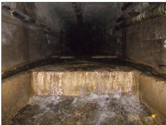
Foto 3 - Panoramica - setto di diramazione canalette
