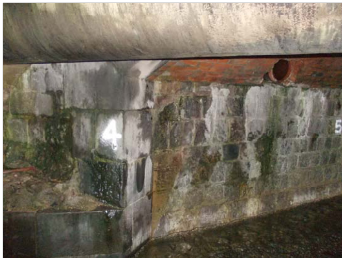
Foto 2 - Panoramica piedritto dx - ghiaia depositata
