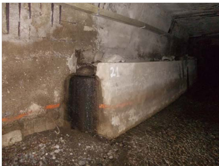
Foto 2 - Piedritto sx - canaletta laterale - canaletta per cavi
