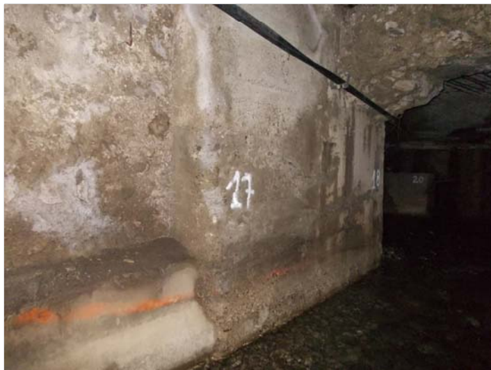
Foto 2 - Panoramica piedritto dx - infiltrazione dalla superficie
