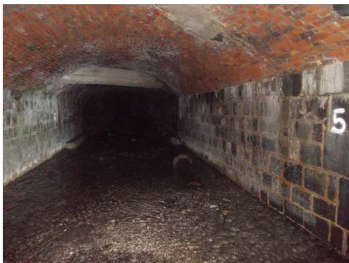
Foto 3 - Panoramica copertura a volta in mattoni pieni
