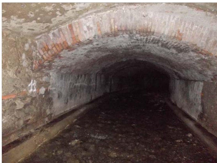
Foto 3 - Vista verso valle - cambio sezione
