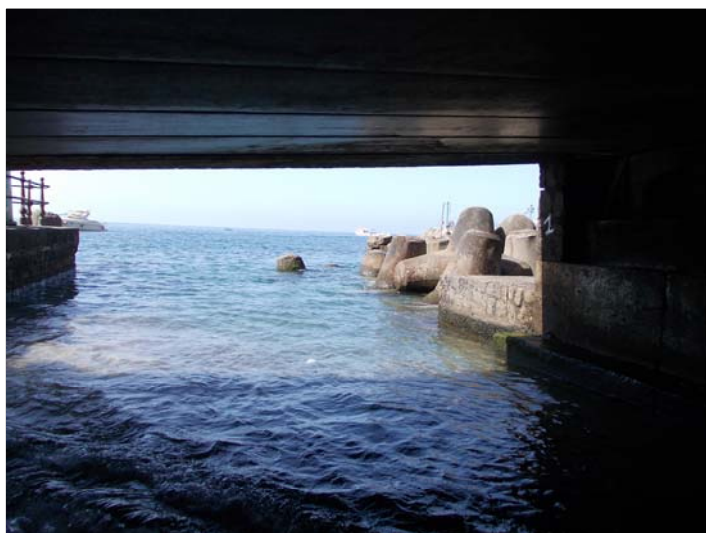
Foto 3 - Sbocco vista verso il mare
