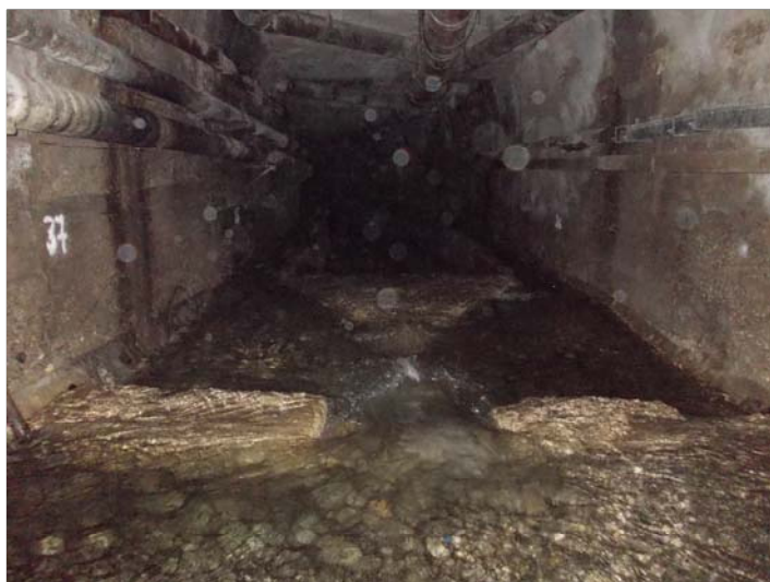
Foto 3 - Panoramica - setto di diramazione canalette
