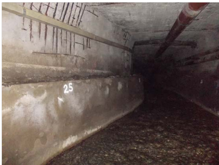
Foto 1 - Piedritto sx - canaletta laterale - ghiaia depositata
