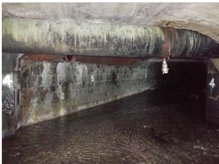
Foto 3 - Attraversamento condotta idrica Dn 600
