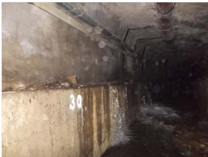
Foto 1 - Piedritto sx - canaletta laterale - ghiaia depositata
