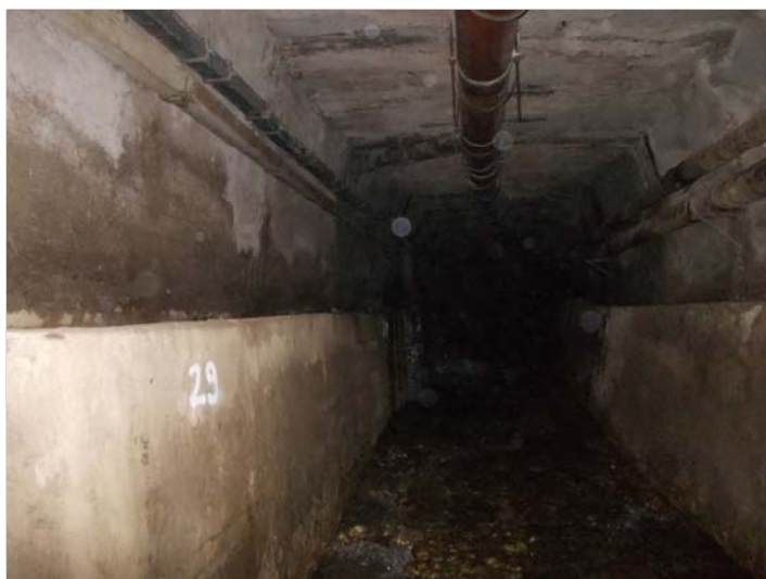
Foto 2 - Piedritto sx - canaletta laterale - ghiaia sul fondo
