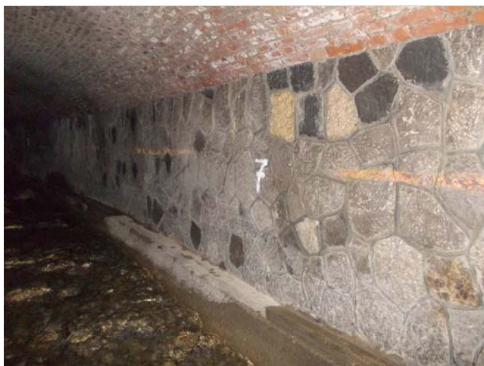
Foto 2 - Panoramica piedritto dx - ghiaia depositata
