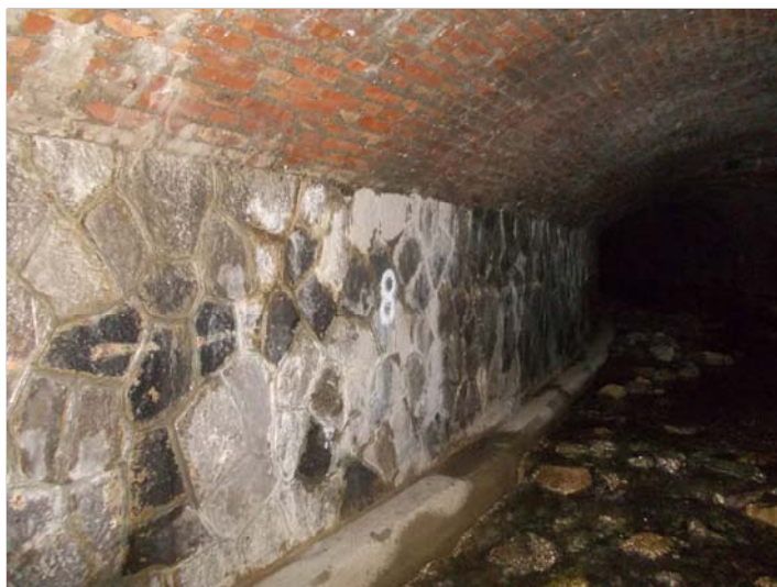
Foto 1 - Panoramica piedritto sx - ghiaia depositata sul fondo
