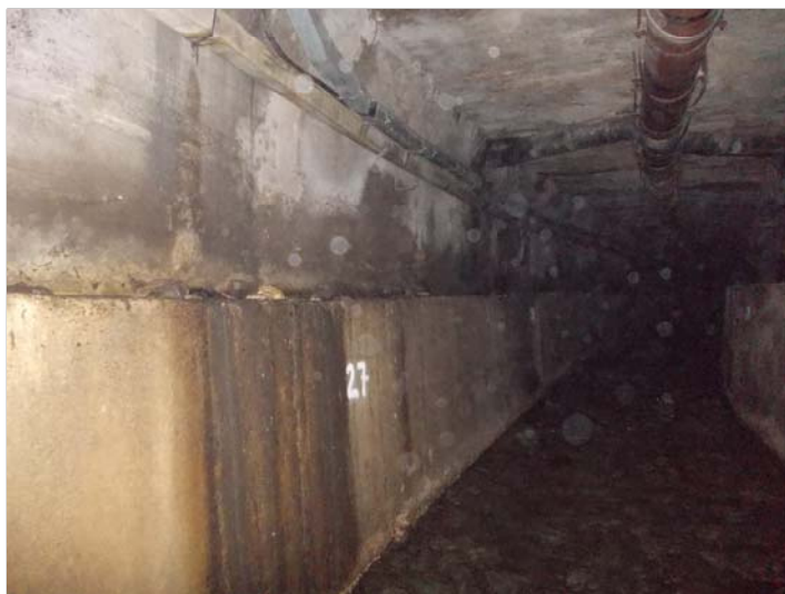
Foto 1 - Piedritto sx - canaletta laterale - ghiaia depositata
