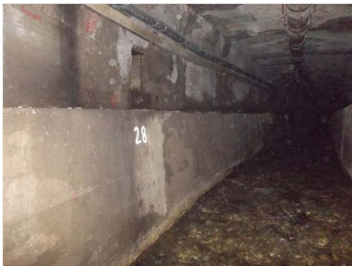
Foto 1 - Piedritto sx - canaletta laterale - ghiaia depositata
