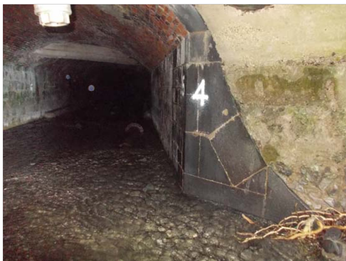
Foto 2 - Panoramica piedritto dx - ghiaia depositata
